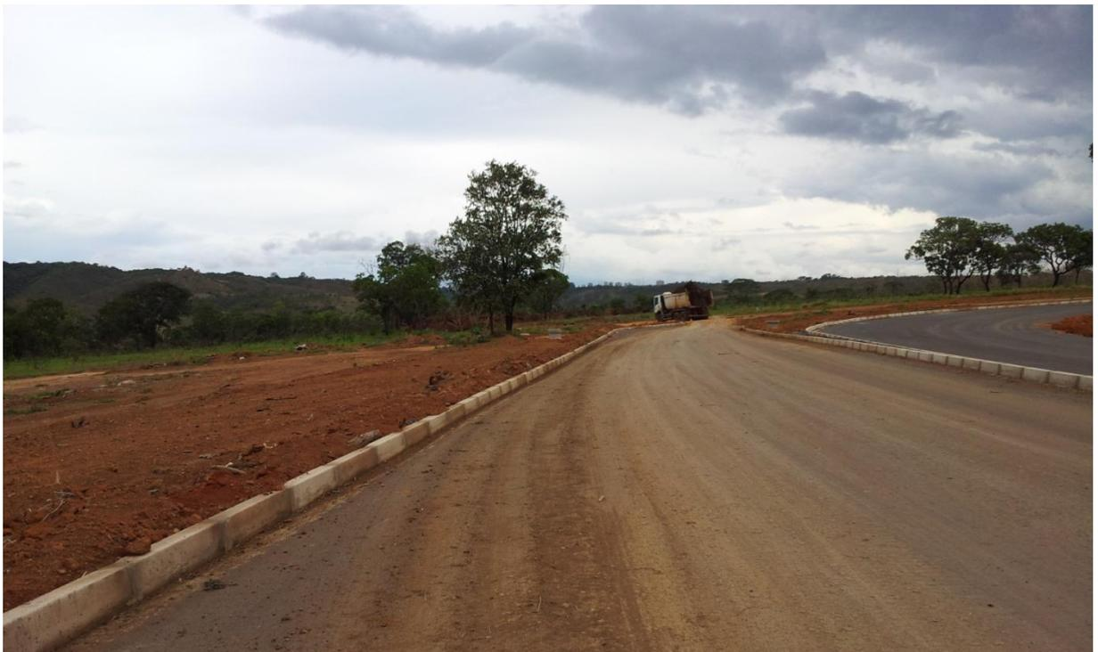
Trecho asfaltado e com parte do meio-fio implantado - 11 de julho de 2014
