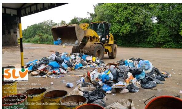
**Figura 3** - Quarreamento dos resíduos sob superfície impermeabilizada.
