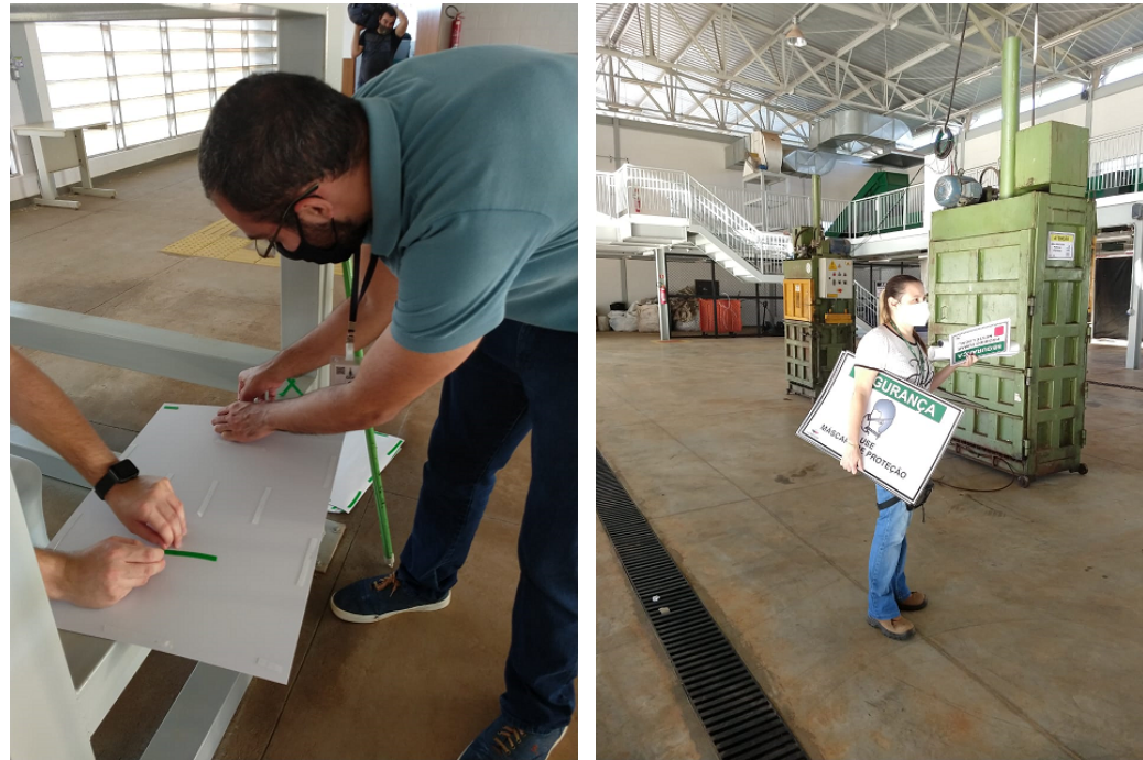
Sinalização de Segurança do Complexo de Reciclagem da Estrutural
