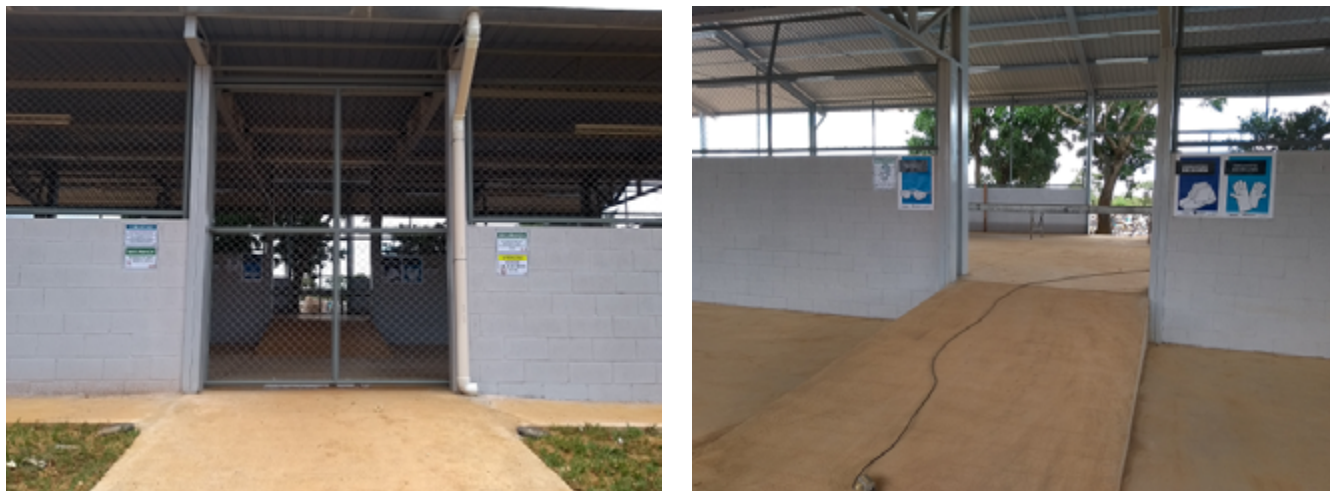
Figuras 36 e 37 – Sinalização de Segurança IRR Brasília.
