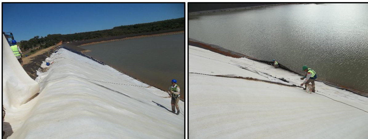
Figura 05: Instalação de Barreira Geossintética - GCL
