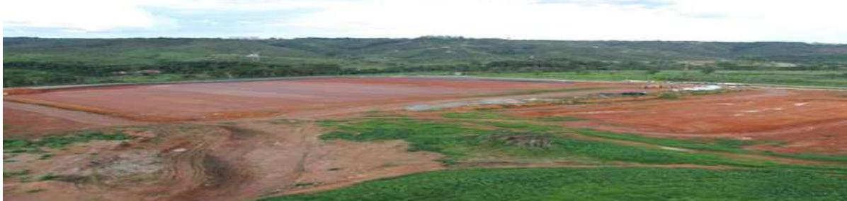
Foto 9: Aterro Sanitário de Brasília. Detalhes: compactação de resíduos, dreno de gases e material para cobertura. Ao fundo, manta protetora da célula de aterramento.
