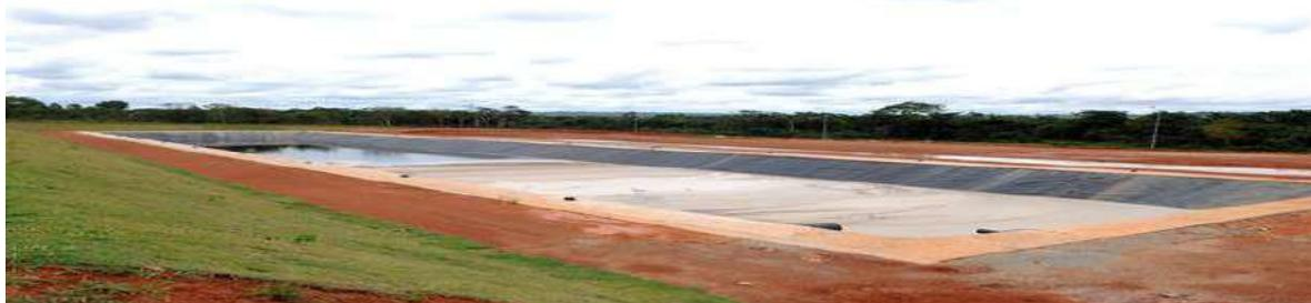
Foto 12: Tanques para recebimento de águas pluviais
