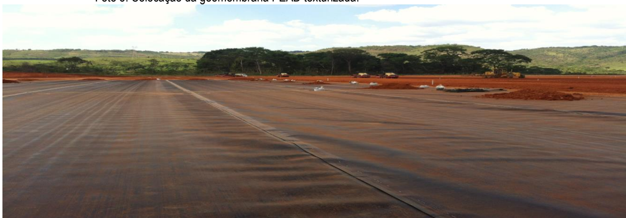
Foto 5: Colocação da geomembrana PEAD texturizada.
