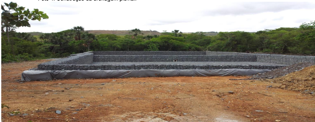
Foto 5: Colocação da geomembrana PEAD texturizada.
