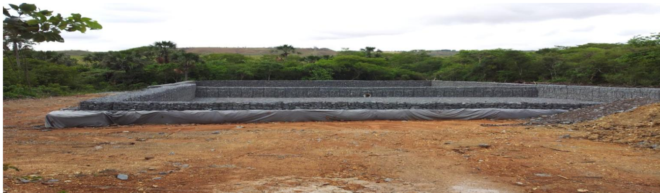
Foto 4: Construção da drenagem pluvial
