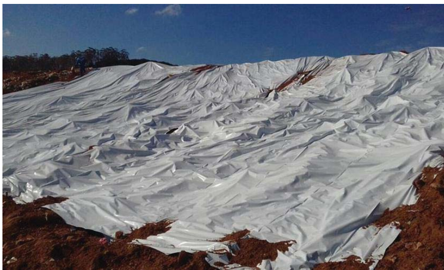
Cobertura temporária aplicada sobre os resíduos
