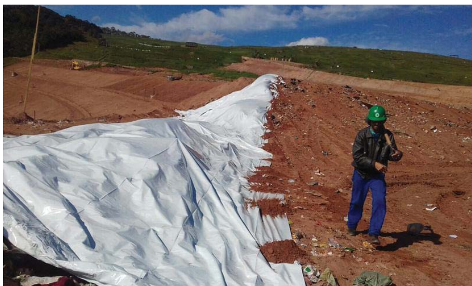
Detalhe da colocação
