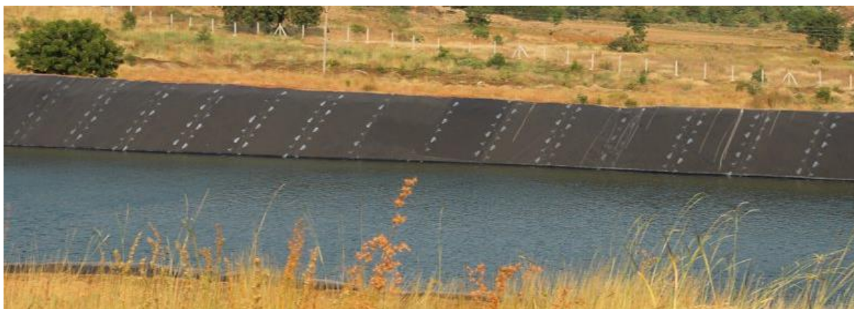
Canais de adução e irrigação
