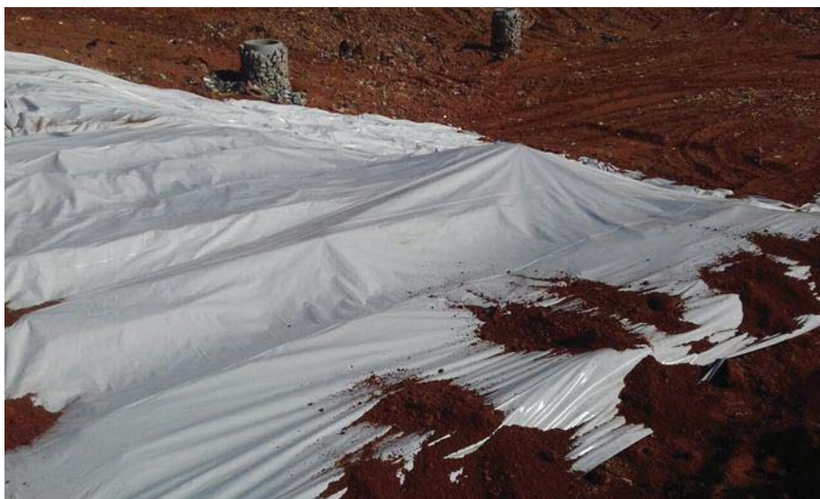
Detalhe da colocação
