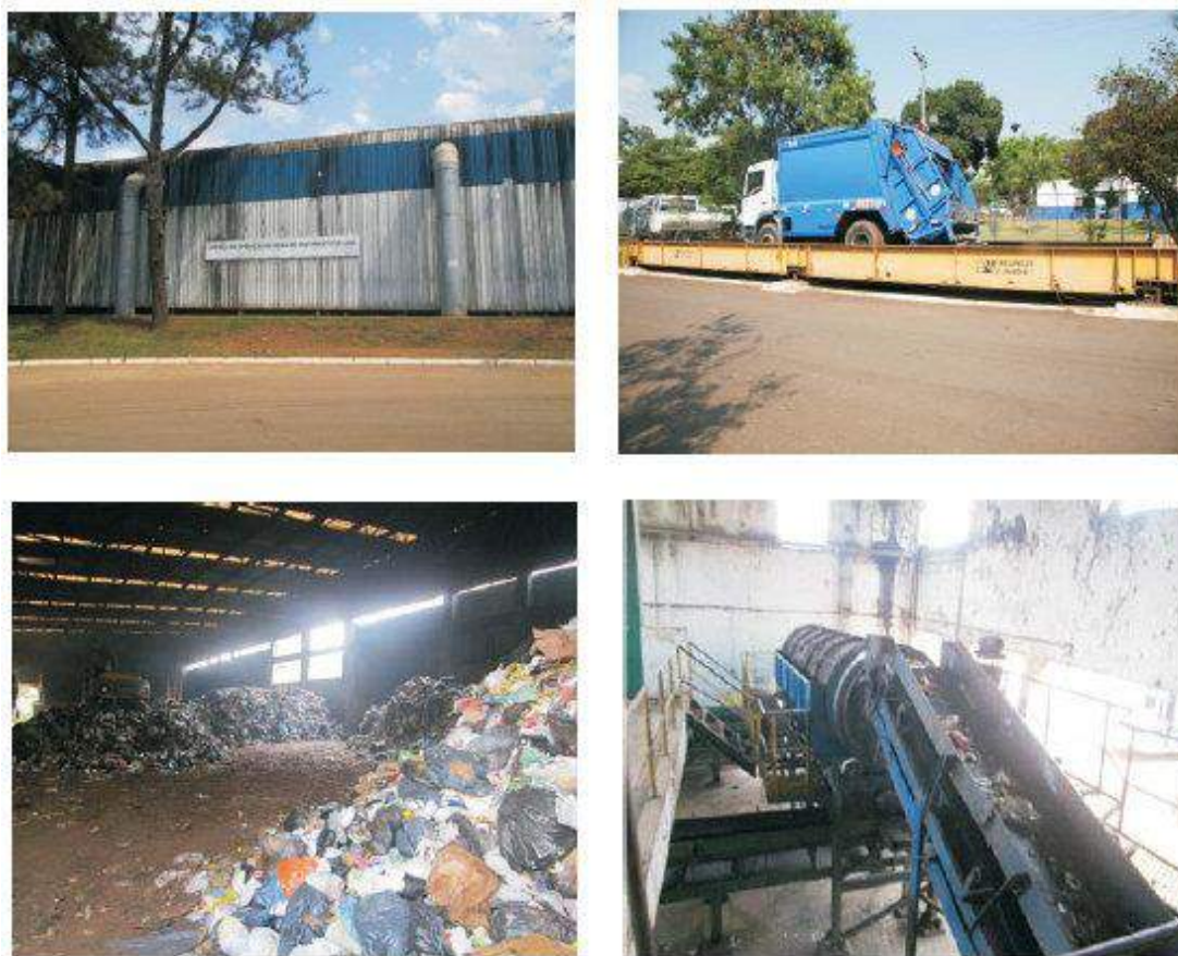
Figura 16 - Imagens da situação atual da UTL -Asa Sul.
