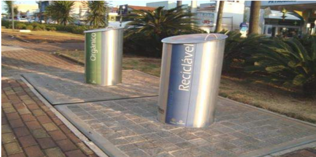
Figura 52 - Coletores do sistema de coleta semi-enterrada
